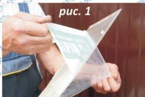
2. Удалить защитную пленку с обеих сторон сотового поликарбоната, отметив маркером сторону, которая защищена от воздействия солнечных лучей (обозначена на защитной пленке символом "солнышко", или надписью или цветной наклейкой) рис. 1.
